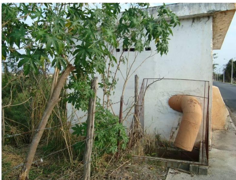
Foto 13 – Estação de bombeamento das águas pluviais.
