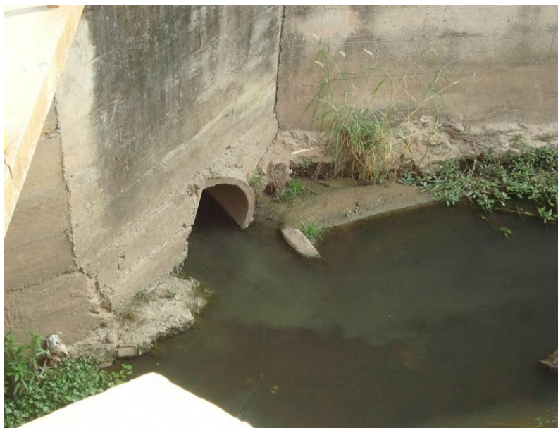
Foto 06 – Contribuições de esgoto que atingem o córrego Mandi pelas galerias de águas pluviais.
