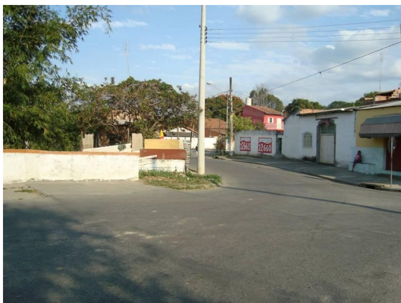
Foto 15 – Área baixa localizada próxima ao córrego Mandi – detalhe para as bocas de lobo responsáveis pela coleta das águas pluviais.
