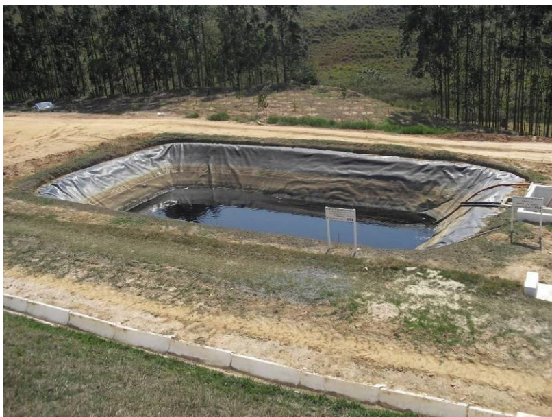
Foto 10 – Tanque Reservatório de Líquidos Percolados (Chorume).
