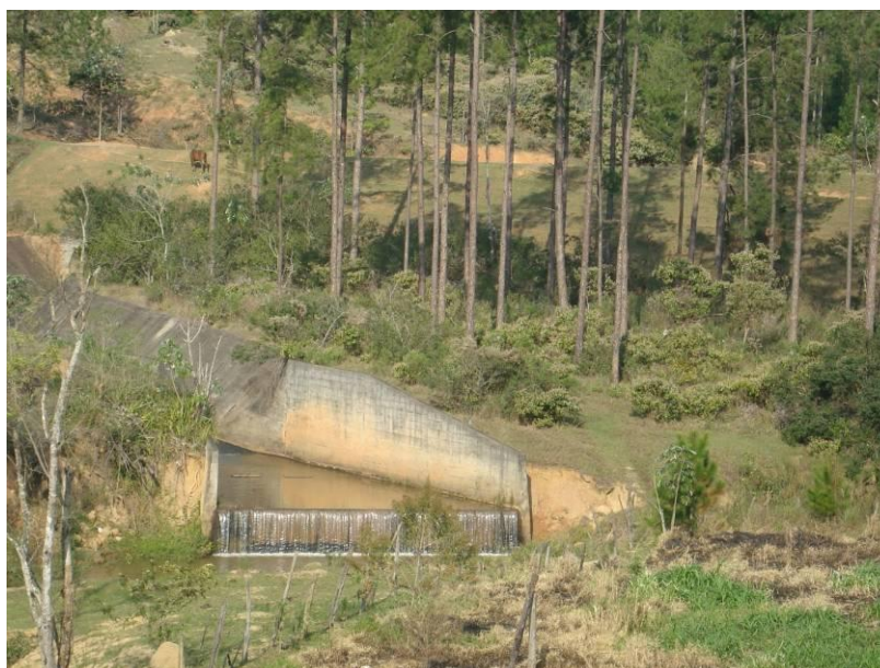
Foto 11 – Vista do canal lateral da barragem de regularização no Córrego Santa Lucrécia.
