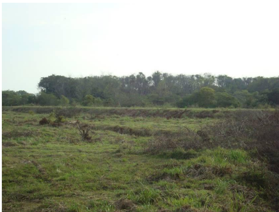
Foto 12 – Dique de proteção contra a elevação das águas do Rio Paraíba do Sul.
