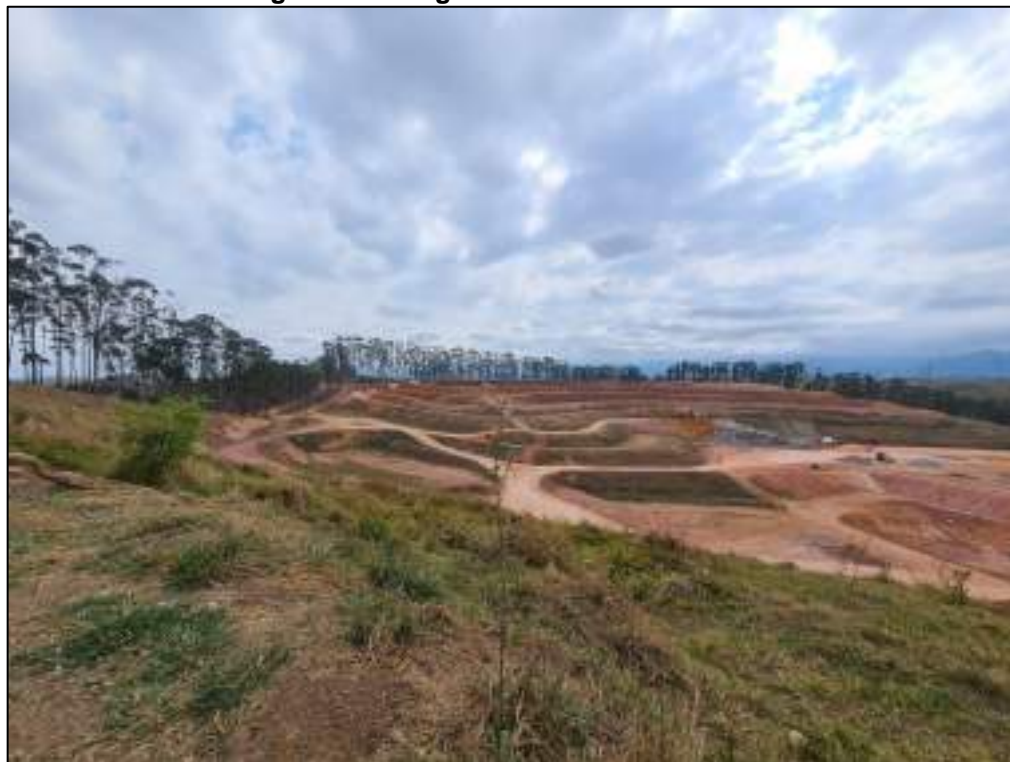
Figura 50 - Imagem Panorâmica do Aterro
