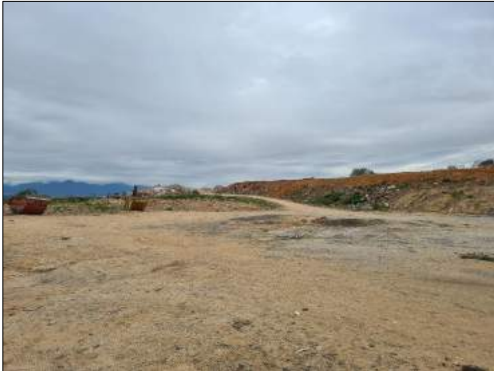
Figura 39 - Pátio de Movimentação dos Caminhões para Descarga.
