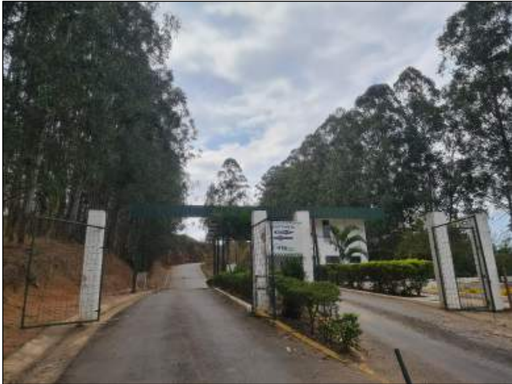
Figura 46 – Entrada do Aterro Sanitário VSA-Vale Soluções Ambientais.
