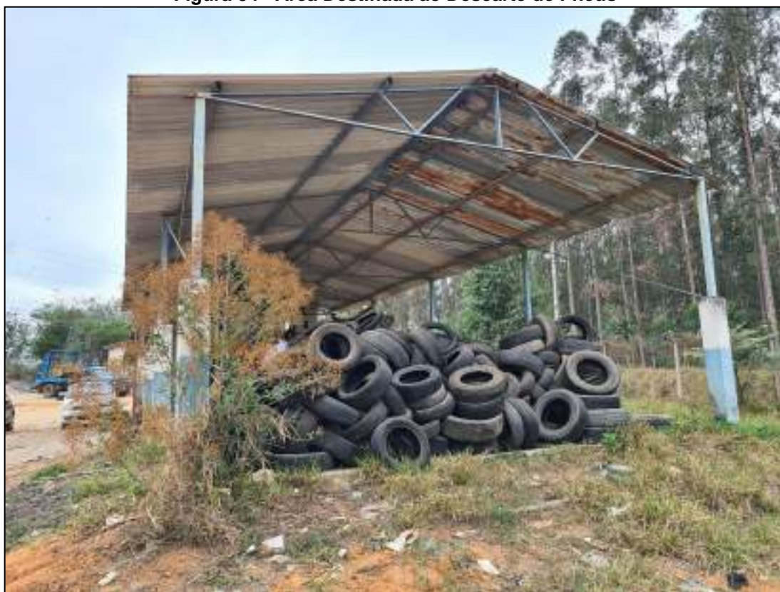
Figura 34 - Área Destinada ao Descarte de Pneus
