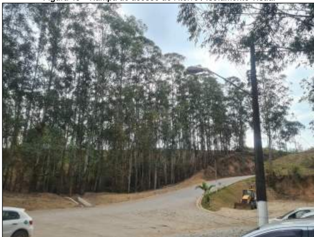
Figura 48 – Rampa de acesso ao Aterro / Isolamento visual
