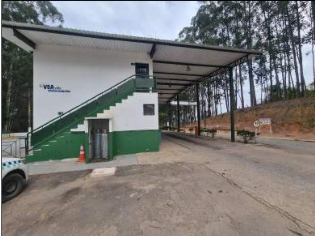
Figura 47 – Balança para Pesagem dos Caminhões
