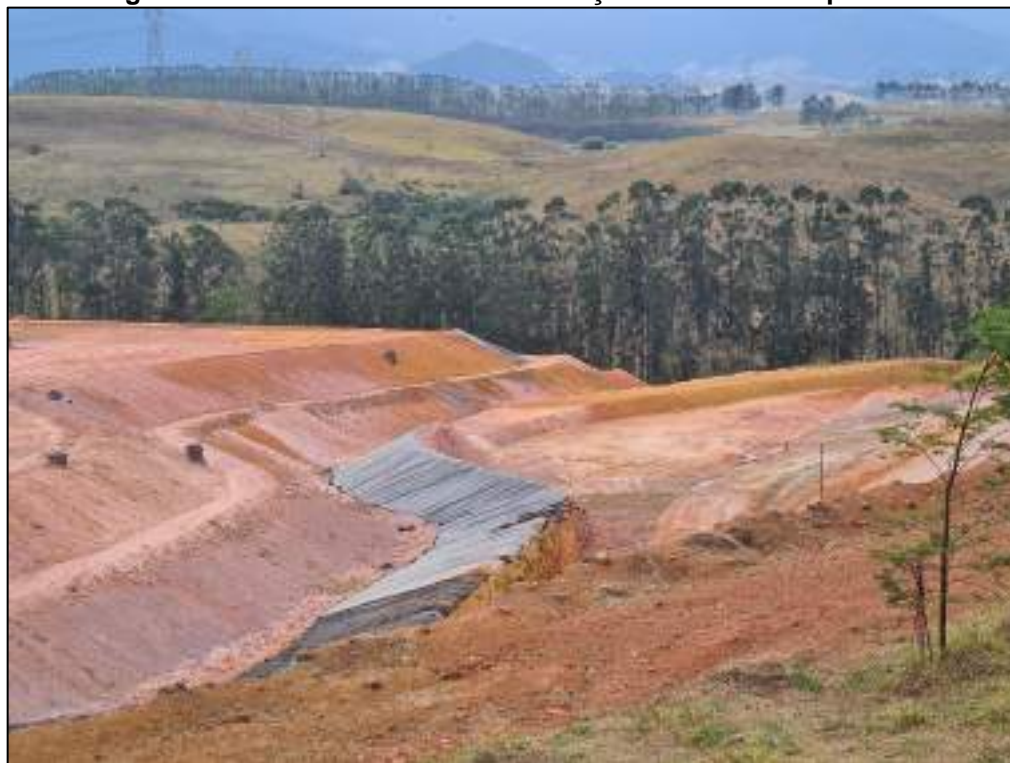
Figura 51 - Área Coberta sem a Presença de Resíduos Expostos.
