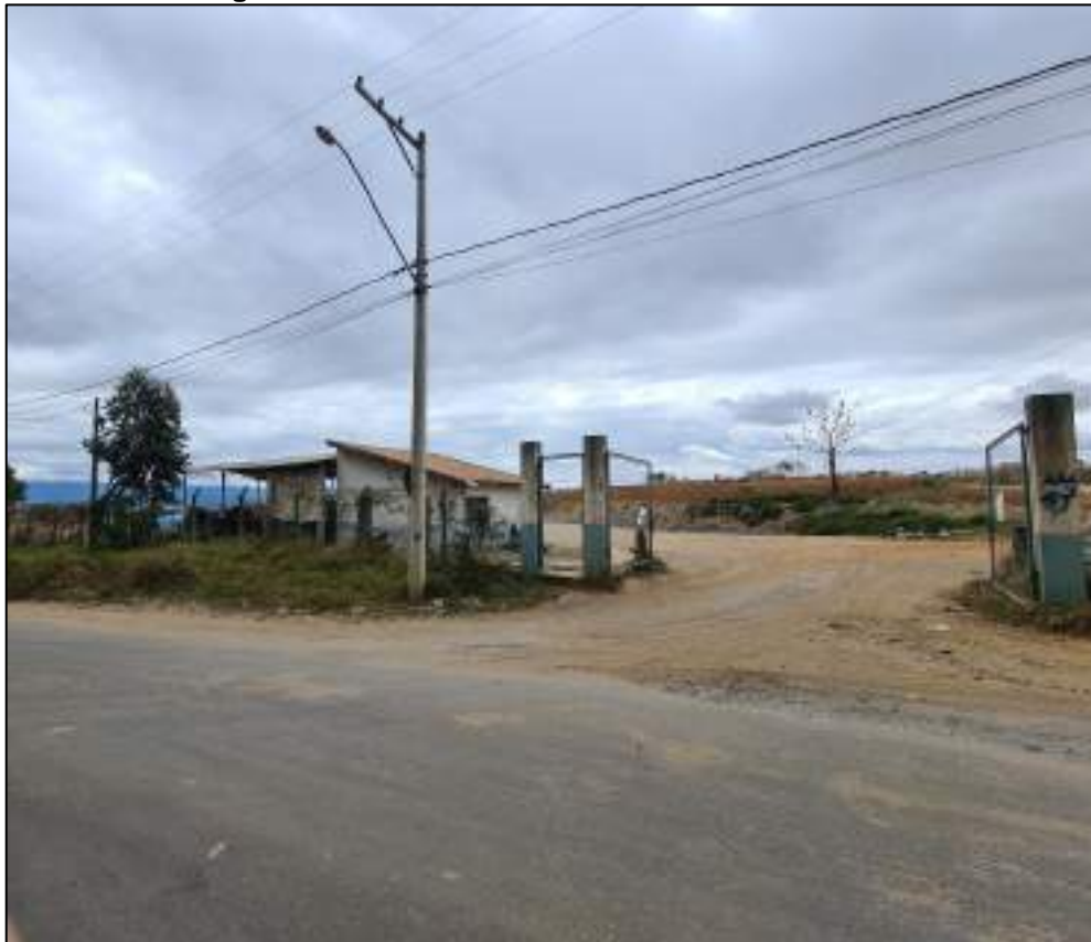
Figura 38 - Entrada do Aterro de Resíduos Inertes
