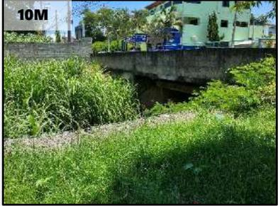
Travessia em Ponte - H = 4,4m e B= 4,6m
