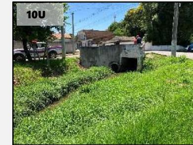
Travessia em Ponte - H = 2,2m e B= 3,3m
