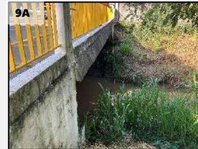
Travessia em Ponte - H = 4,0m e B= 13,0m
