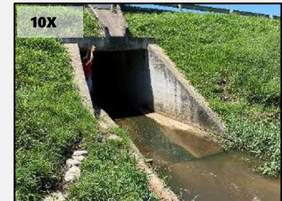
Travessia em Ponte - H = 2,8m e B= 2,5m
