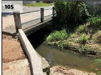
Travessia em Ponte - H = 1,6m e B= 4,0m
