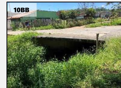
Travessia em Ponte - H = 1,6m e B= 5,5m
