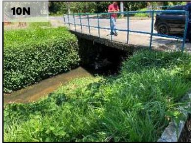
Travessia em Ponte - H = 2,2m e B= 6,2m
