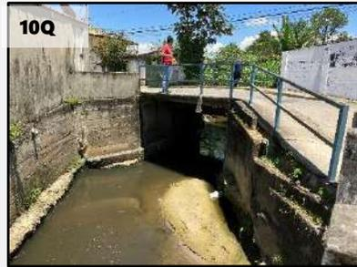
Travessia em Ponte - H = 2,6m e B=3,6m
