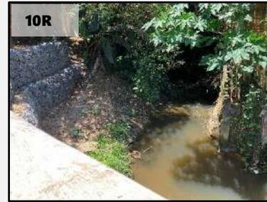
Travessia em Ponte - H = 1,5m e B= 2,8m
