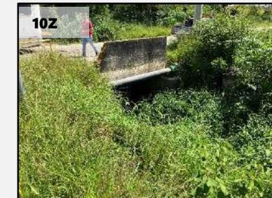
Travessia em Ponte - H = 1,9m e B= 3,4m
