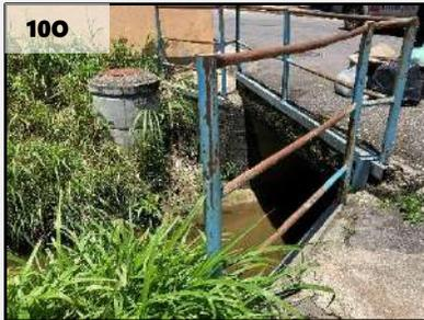
Travessia em Ponte - H = 1,6m e B= 2,5m
