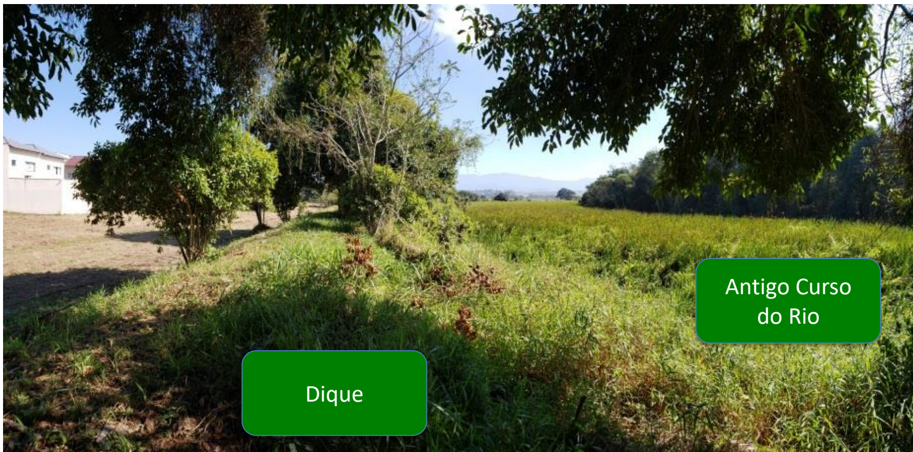
Fonte: Dique de Contenção do Loteamento Parque Residencial Nova Lorena
