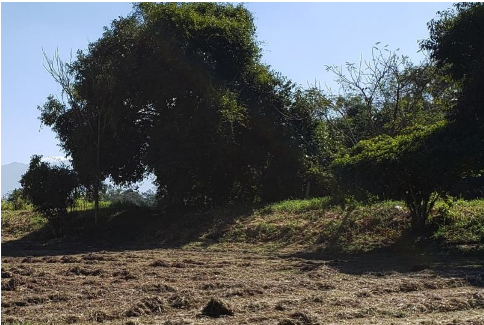
Fonte: Dique de Contenção do Loteamento Parque Residencial Nova Lorena
