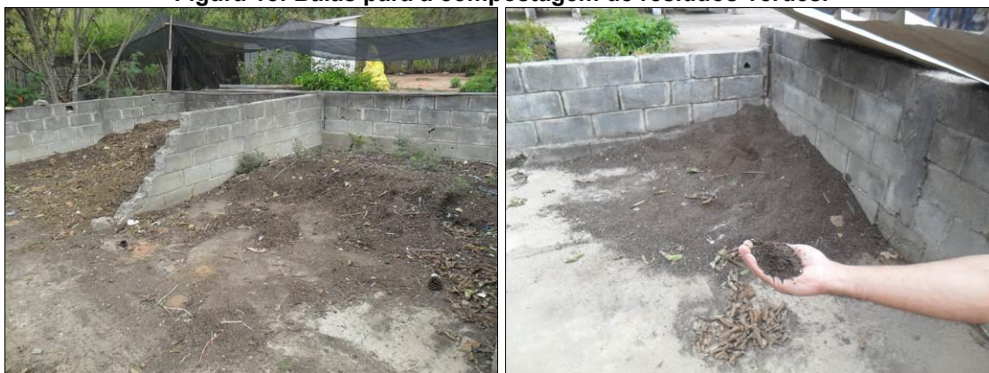
Figura 18: Baías para a compostagem de resíduos verdes.
