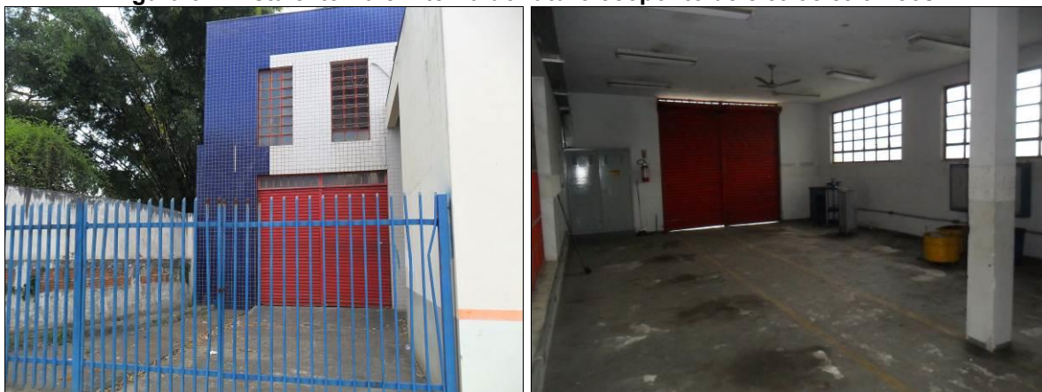
Figura 32: Vista externa e interna do futuro ecoponto de eletroeletrônicos.
