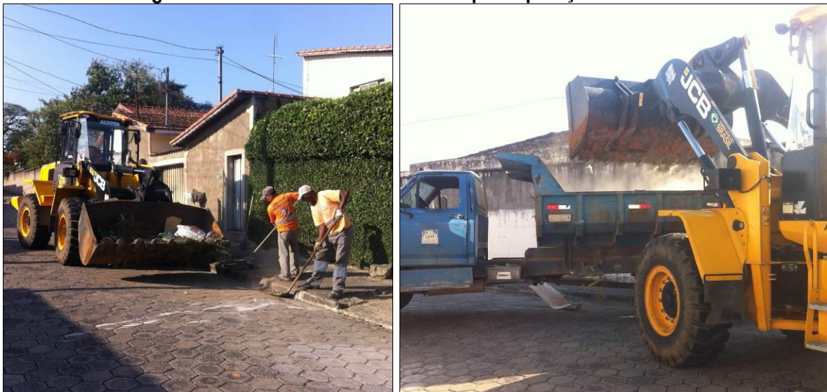
Figura 21: Resíduos sendo coletados pela operação cata-treco.
