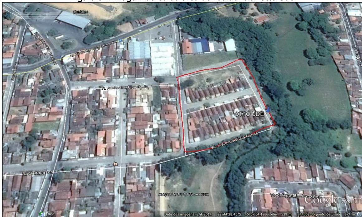
Figura 34: Imagem aérea da área do residencial Otto Ude.
