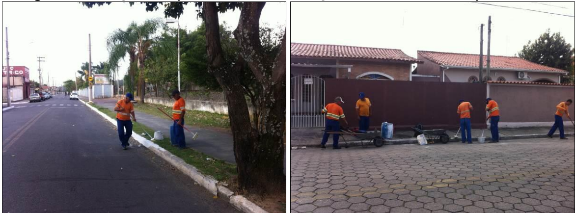
Figura 16: Serviço de limpeza de meio-fio e caiação sendo executado empresa EPPO.
