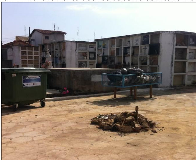
Figura 52: Armazenamento dos resíduos no cemitério municipal.
