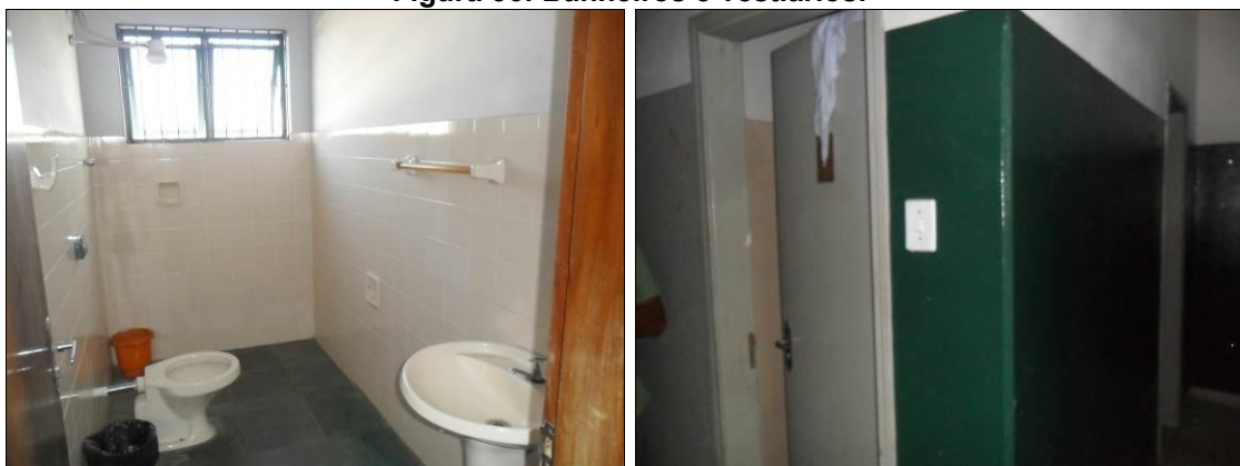
Figura 36: Banheiros e vestiários.
